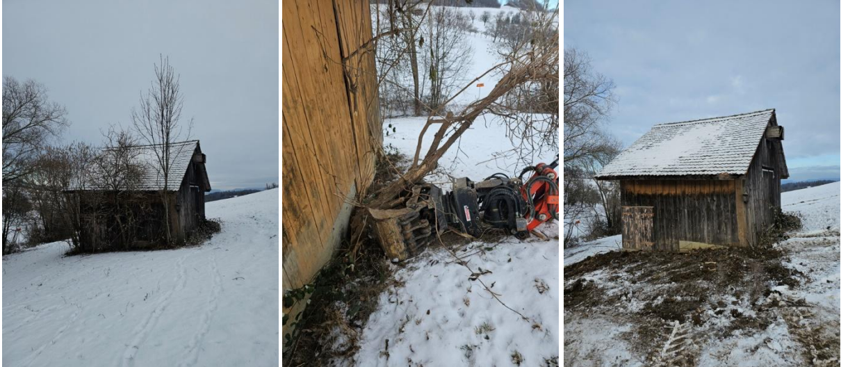
Abbildung 2 Links: Ausgangszustand der Feldscheune. Mitte: Entfernung der eingewachsenen Gehölze. Rechts: Zustand nach der Freilegung.
