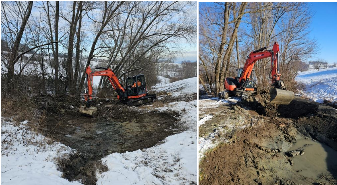
Abbildung 3 Aushub unteres (links) und oberes (rechts) Laichgewässer.
